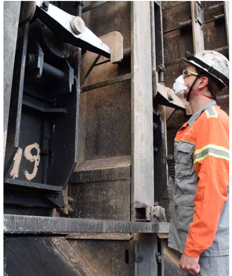
Auch die regelmäßige Überprüfung und Kontrolle der Ofentüren hat oberste Priorität.
