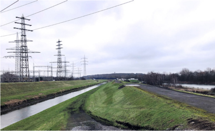
Im Emscherdeich wurden die Rohre bis zu vier Meter unter die Erde gelegt (Fotos: Uniper)
