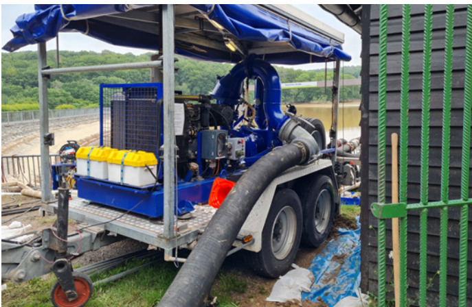
Die Großpumpe des THW Dinslaken im Einsatz
