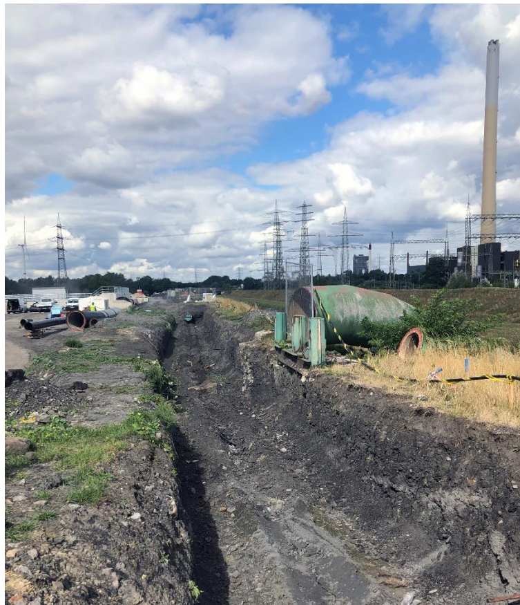
Im vierten Quartal 2022 werden die Arbeiten voraussichtlich abgeschlossen sein und die Gasleitung wieder vollständig unterirdisch verlaufen.
